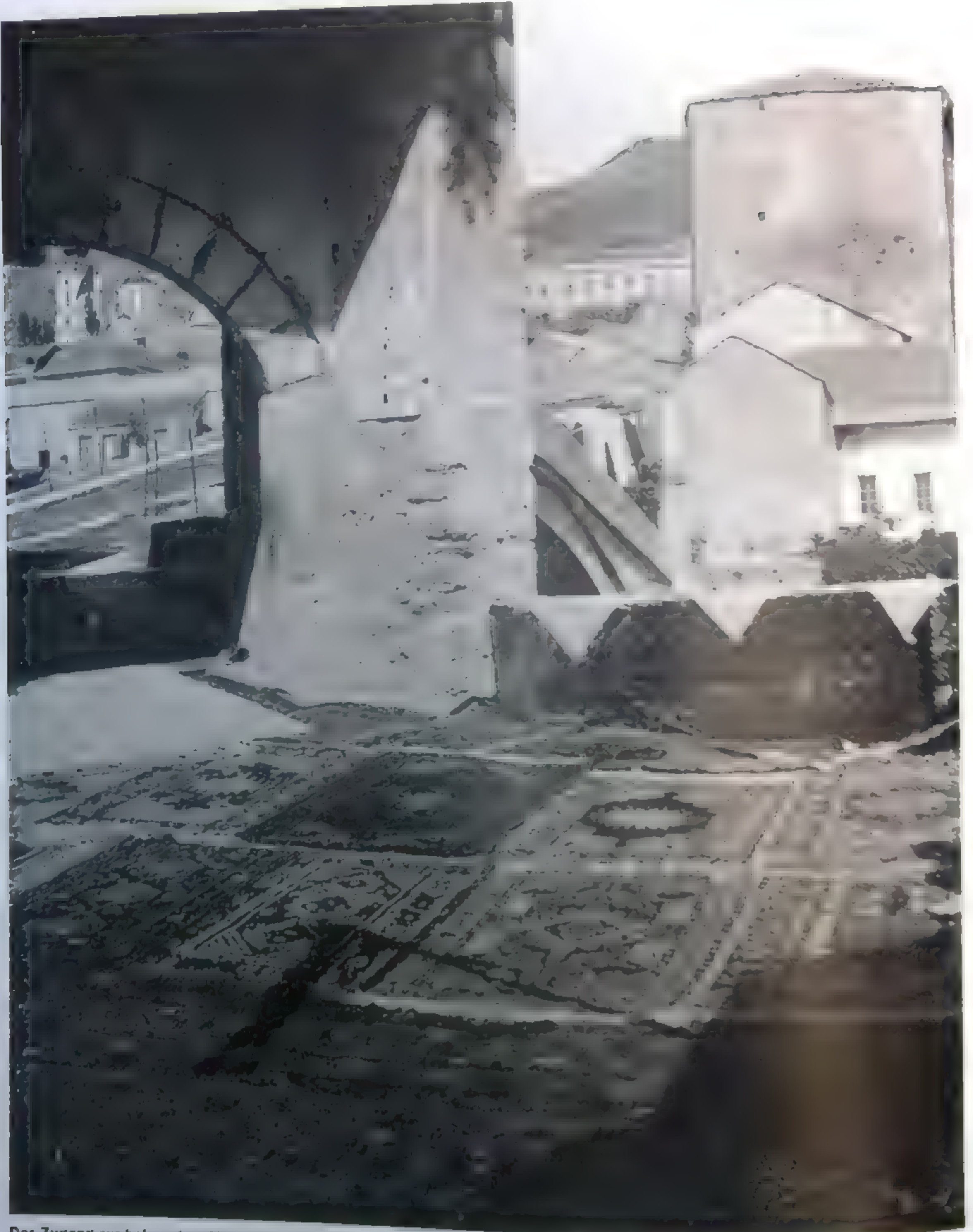
Der Zugang zur bekannten Alten Brücke in Mostar wurde mit kostbaren Teppichen ausgelegt.
